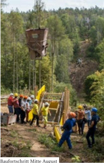
Baufortschritt Mitte August
