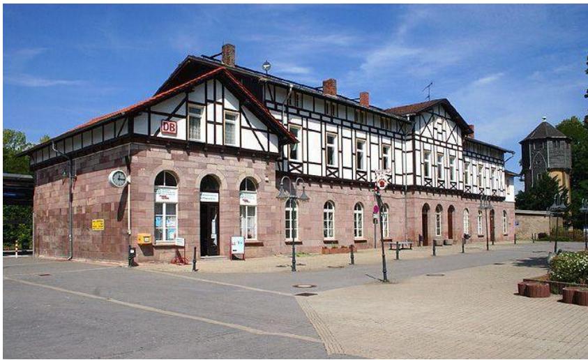
Blick auf den Residenzbahnhof
