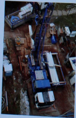
Der Bohrplatz und das Bohrgerät der Forschungsbohrung von der Glockenstube des schiefen Turms der Oberkirche aus aufgenommen.
