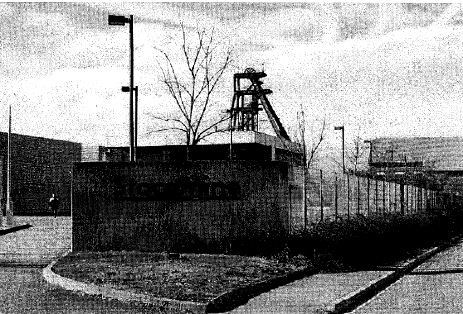
Problematisch: Das Gelände von Stocamine Foto: Nückles
