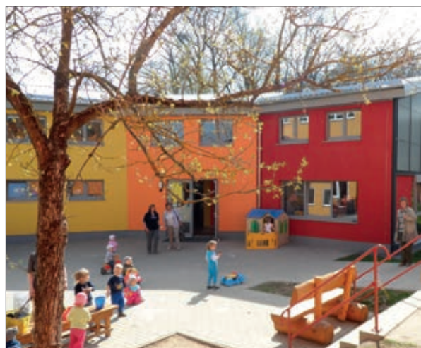
Eingangsbereich von Schule und Kindergarten Foto: Amt für Landentwicklung und Flurneuordnung Gera
