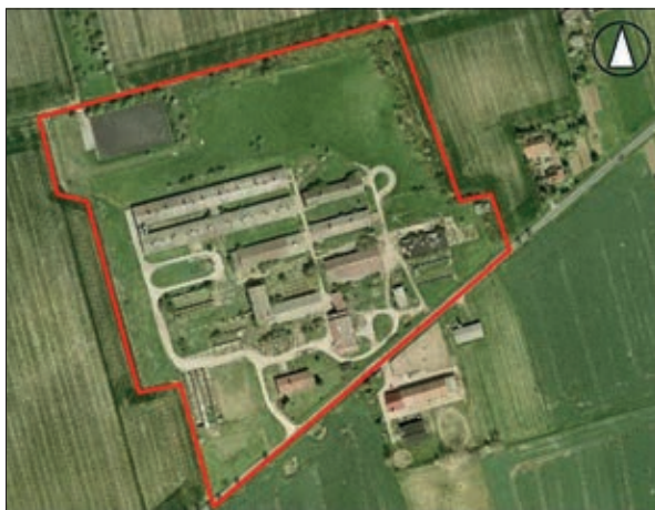
Luftbild der Stallanlage in Ballstädt aus dem Jahr 2008 mit der nördlich gelegenen Güllelagune (Fassungsvermögen 3.000 m 3 ), den Stallungen und Lagerräumen sowie den Anlagenteilen im Teilabbruch
