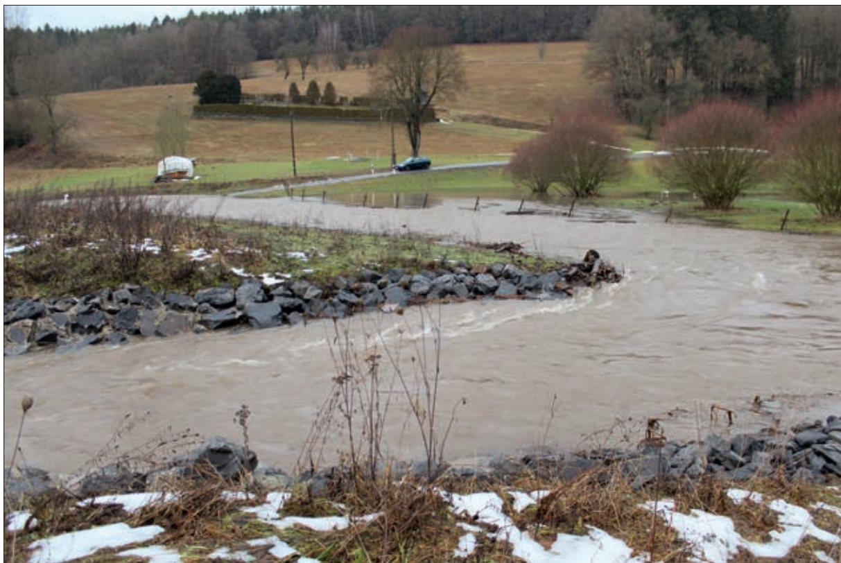
Flutmulde in Betrieb Foto: Rainer Blechschmidt
