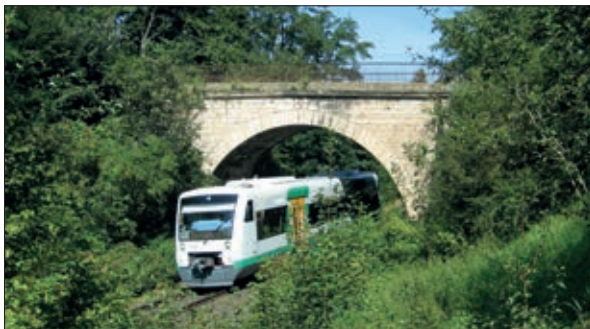
Totalansicht der Brücke vor der Sanierung Foto: Amt für Landentwicklung und Flurneuordnung Gotha (August 2012)
