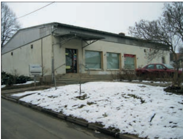
Die ehemalige Kaufhalle vor dem Umbau Foto: Wolfram Schindler
