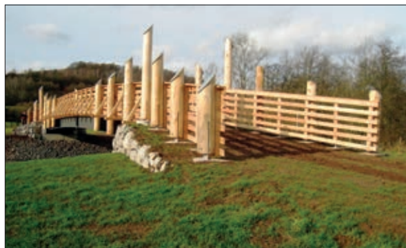
Wander- und Landwirtschaftsbrücke im Verfahren Buttlar Foto: Verband für Landentwicklung und Flurneuordnung Thüringen
