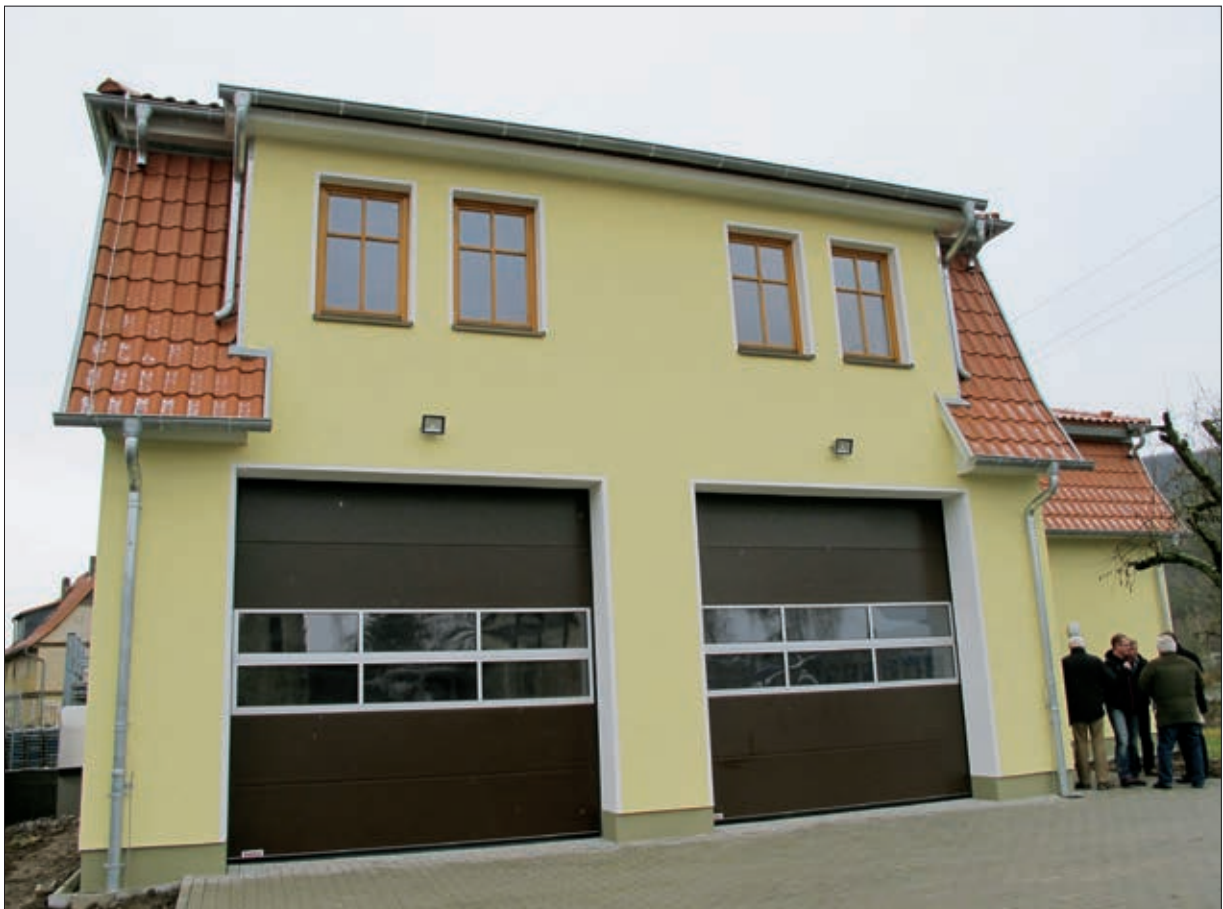
Umgebautes Feuerwehrgerätehaus zum Mehrzweckgebäude Foto: Thüringer Landgesellschaft mbH
