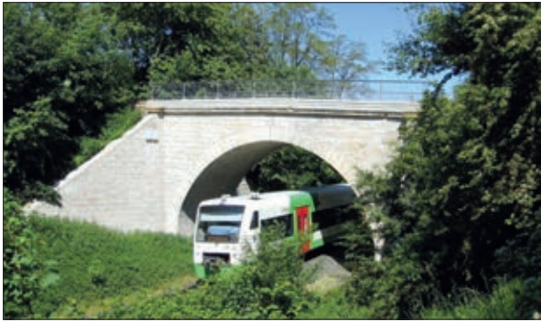
Totalansicht der Brücke nach der Sanierung Foto: Amt für Landentwicklung und Flurneuordnung Gotha (Juni 2013)
