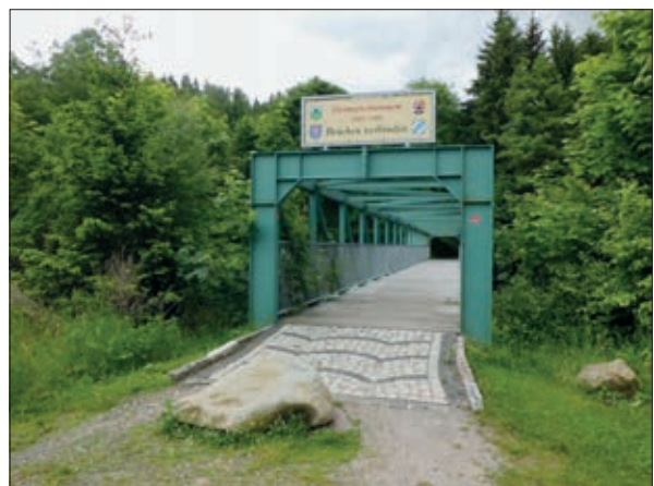
Sanierte und neugestaltete Saalebrücke
