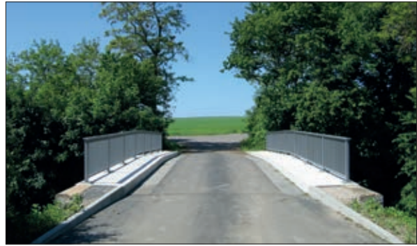
Brückenfahrbahn nach der Sanierung Foto: Amt für Landentwicklung und Flurneuordnung Gotha (Juni 2013)
