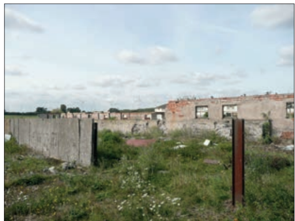
Bereits erfolgter Teilabbruch durch den Anlagenbetreiber im Vorfeld der Renaturierungsmaßnahme Quelle: Thüringer Landgesellschaft mbH (Juli 2011)
