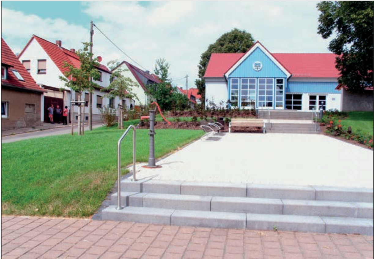
Das neue Bürgerhaus Nägelstädt Foto: Wolfram Schindler
