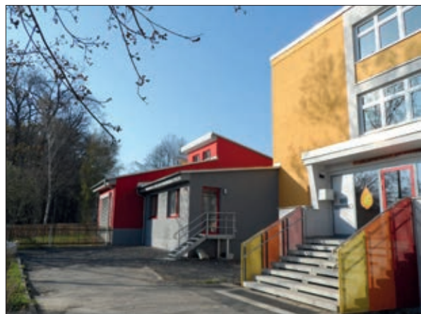
Eingangsbereich von Schule und Kindergarten Foto: Amt für Landentwicklung und Flurneuordnung Gera
