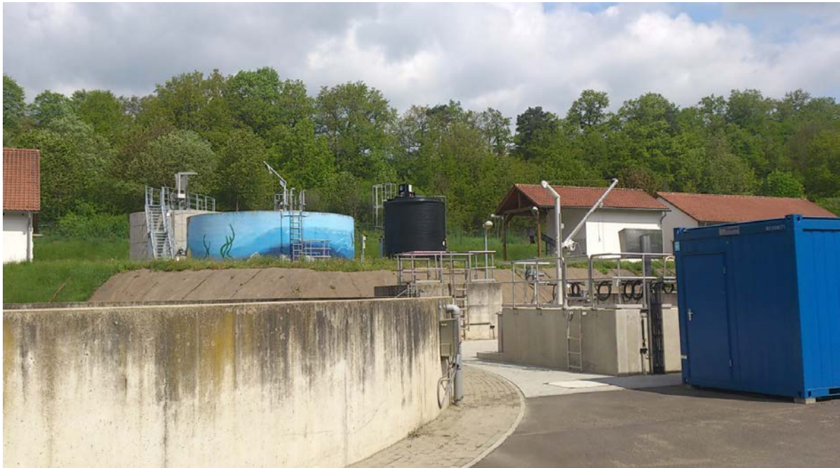
Rekonstruierte Kläranlage Ronneburg mit einer Ausbaugröße für 10.000 EW
