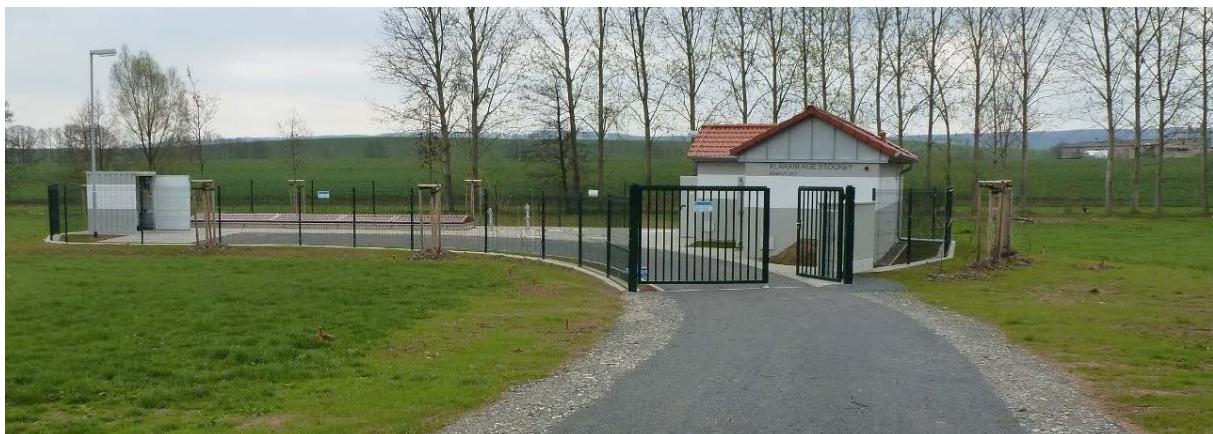
Kläranlage Stöckey mit einer Ausbaugröße für 400 EW
