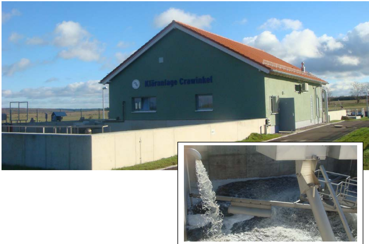
Kläranlage Crawinkel mit einer Ausbaugröße für 1.500 EW Betreiber: Wasser- und Abwasserzweckverband „Apfelstädt-Ohra“
