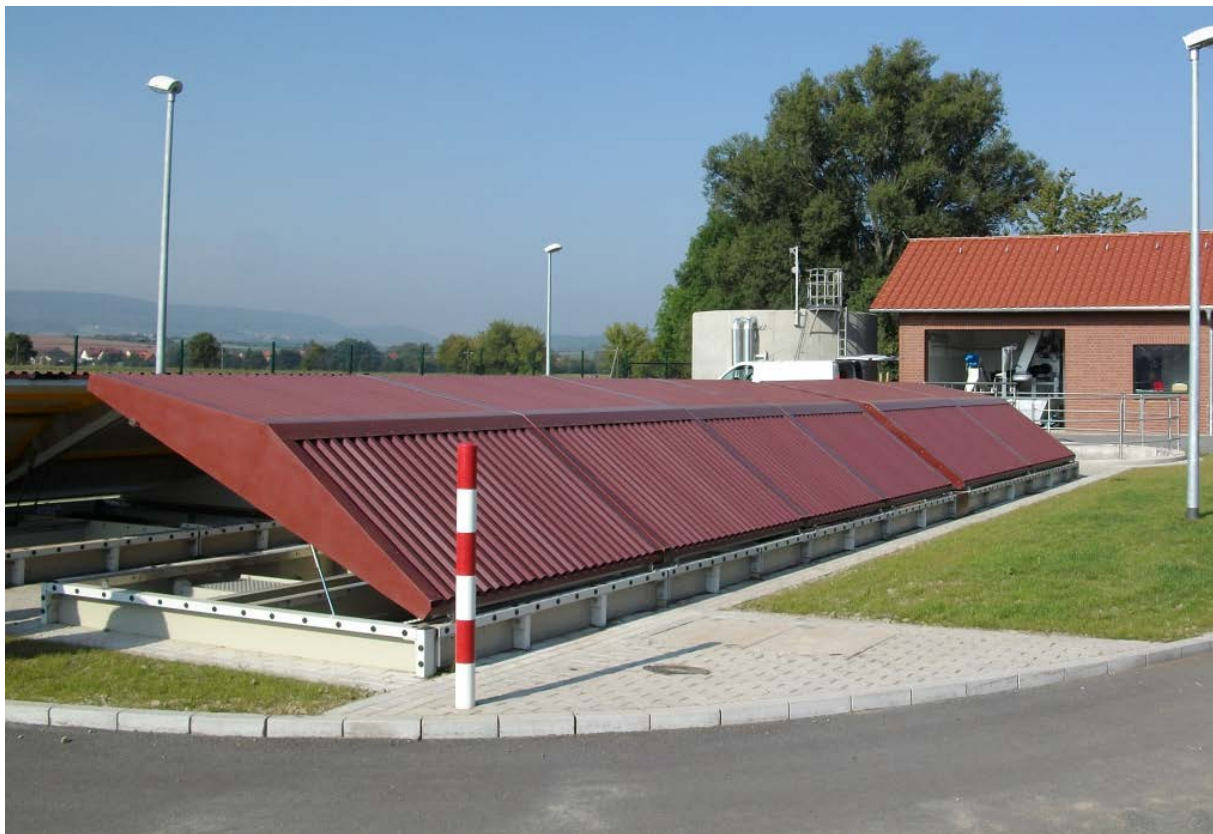
Kläranlage Wollersleben mit einer Ausbaugröße für 1.300 EW Betreiber: Abwasserzweckverband „Bode-Wipper“
