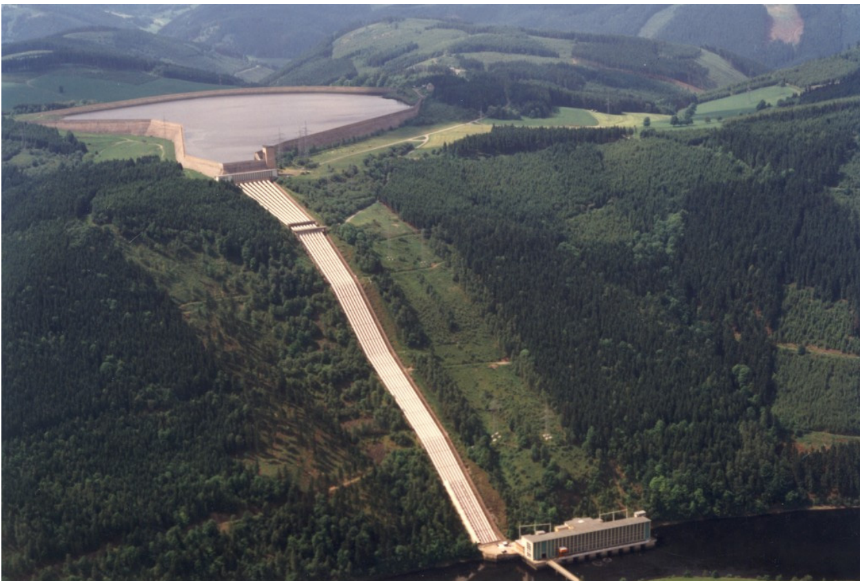
Abbildung 1: Pumpspeicherkraftwerk Hohenwarte II (Quelle: Hydroprojekt Ingenieurgesellschaft mbH)
