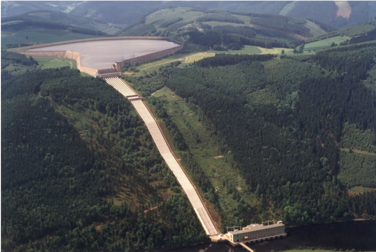
Abbildung 1: Pumpspeicherkraftwerk Hohenwarte II
